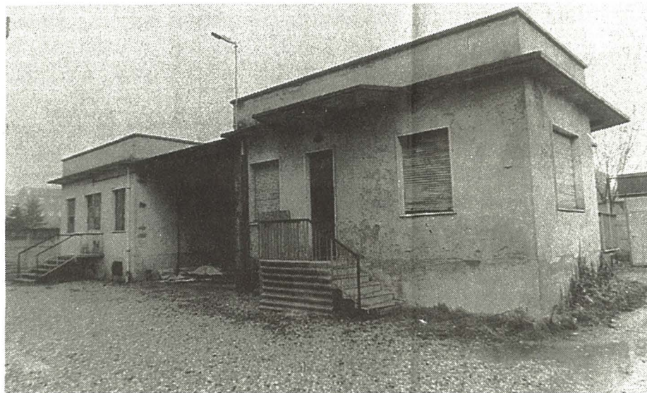
Una volta ristrutturata, la palazzina ex Agam accoglierà venti pazienti fissi e dieci a rotazione
